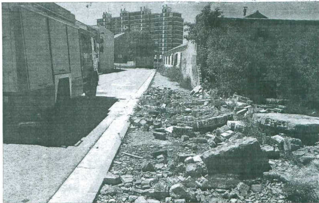
Se cae una tapia en La Ventilla. Los bomberos acudieron ayer al barrio de La Ventilla a comprobar el estado de la tapia de una nave abandonada que se desplomó a mediodía. Una dotación del Cuerpo de Bomberos se desplazó hasta el lugar de los hechos para observar si entrañaba algún riesgo para los viandantes. Sin embargo, la vieja pared cayó al suelo por completo. Así que no hizo falta acordonar la zona ni vallarla para prevenir posibles riesgos a los vecinos. / FOTO: ANGEL AYALA
