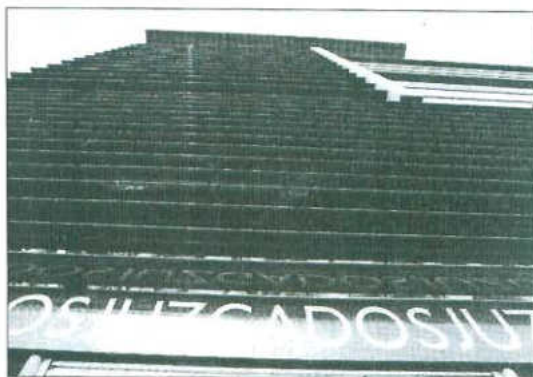
Panorámica de la fachada del acceso a los juzgados. RAMIRO
