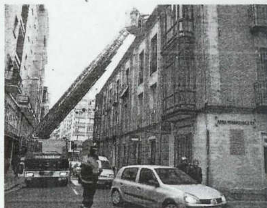
Los bomberos retiran unas tejas en la calle López Gómez. ■ A.M.
