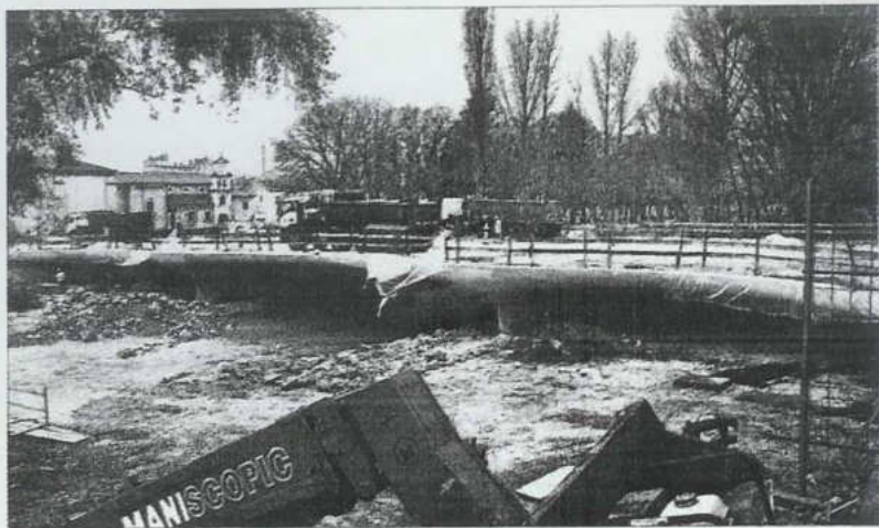
Las pruebas de carga del puente que sustituye al de Gasset se realizaron ayer por la mañana. / ALBERTO RODRIGO
