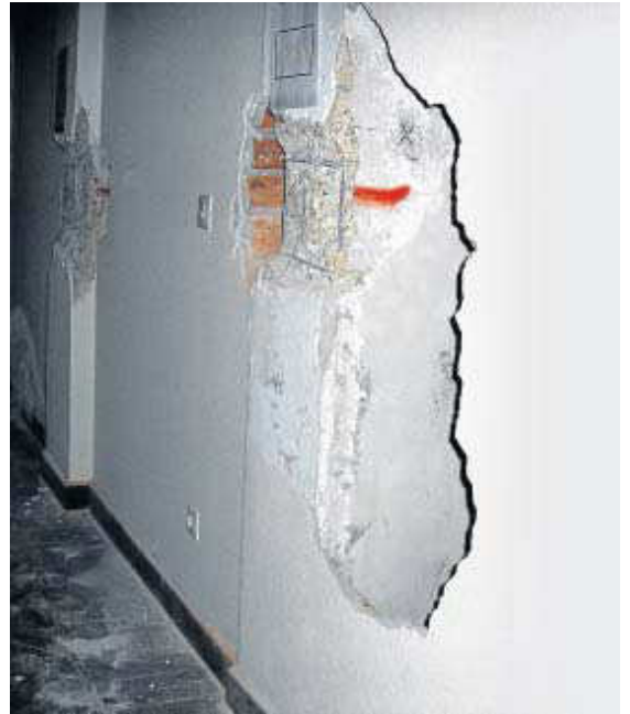
Una muestra de los daños que en estos años ha sufrido el edificio.
