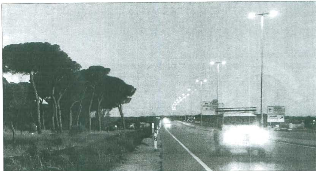
En la carretera CL-600 entre los puntos kilométricos 6,5 y 8,2 se extenderán cuatro tipos diferentes de mezclas bituminosas especiales. / J. C. CASTILLO
