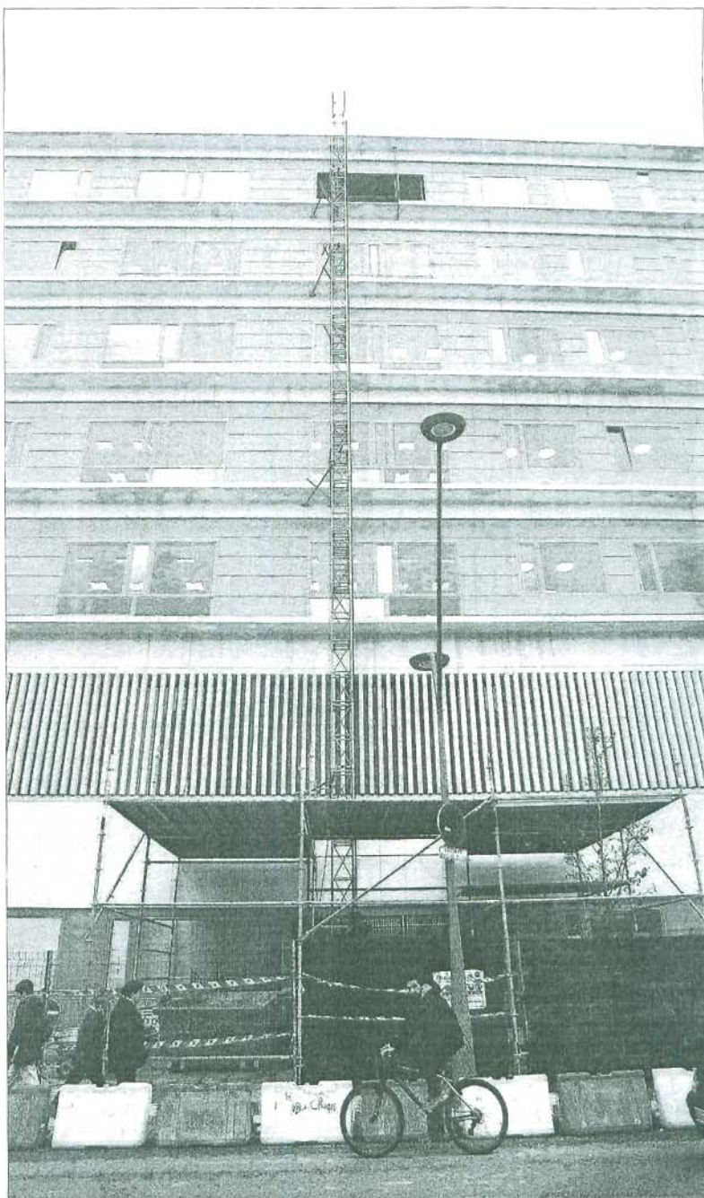
Las últimas obras se realizaron en los juzgados de Reyes Católicos para habilitar la última planta. / M.A. VALDIVIELSO
