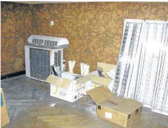
Cajas y enseres acumulados en el sótano del Palacio de Justicia de la Gran Vía.
