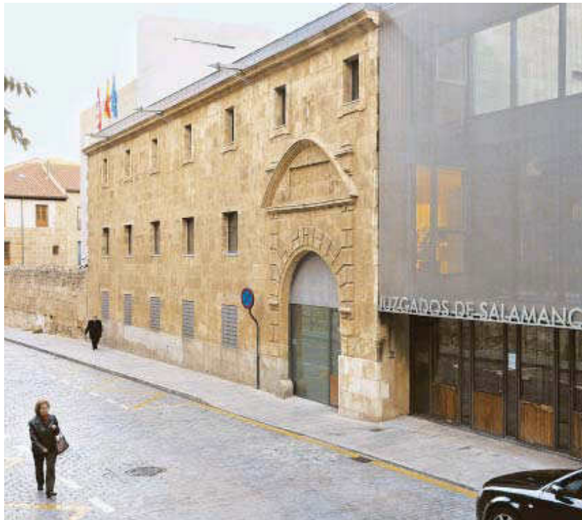
Los juzgados de Salamanca se encuentran reunidos, en su mayor parte, en el edificio de la Plaza de Colón.
